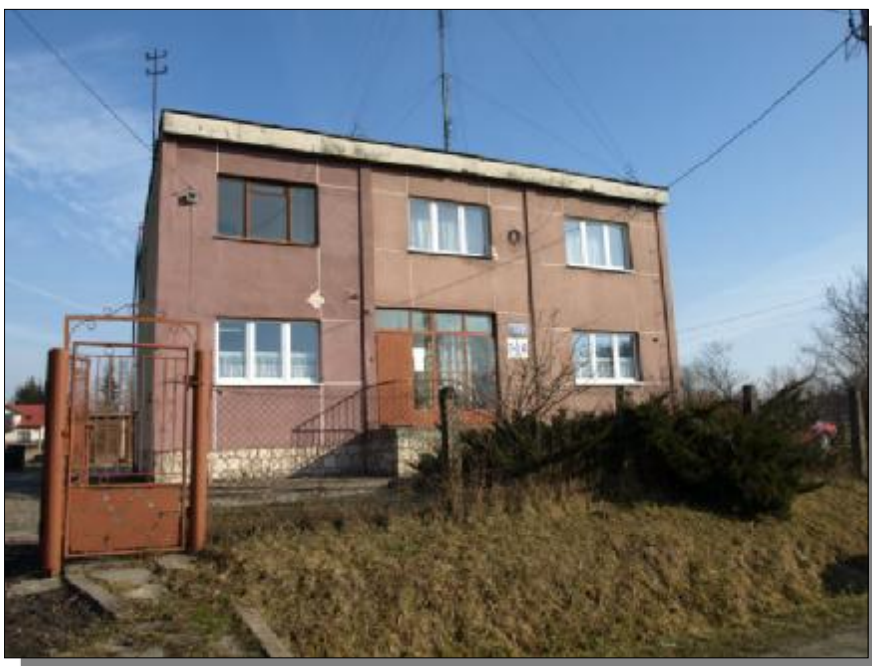
Budynek Ośrodka Zdrowia w Stepocicach
